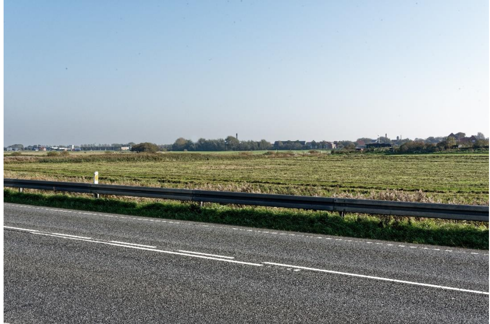
Figur 6.15: Udsigt til planområdet henover Hovedengen, set fra Ringgaden – før og efter. Visualisering: NIRAS
