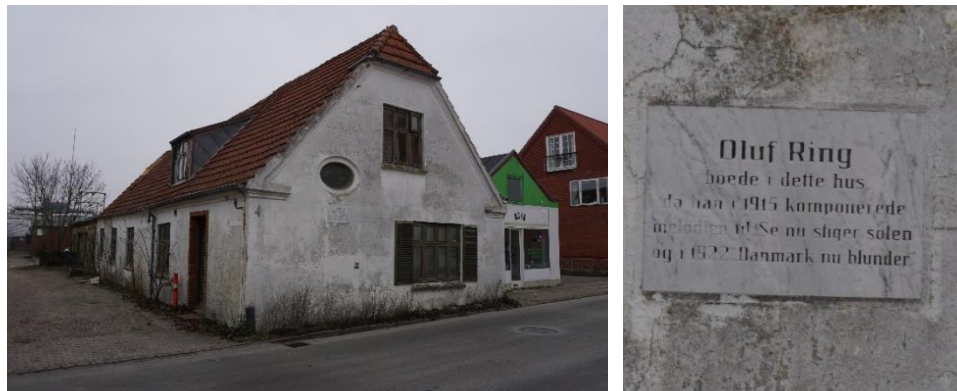
Figur 6.21: De eksisterende bygninger, facaderækken mod Sct. Peders Gade: Sct. Peders Gade 4. Foto: NIRAS
