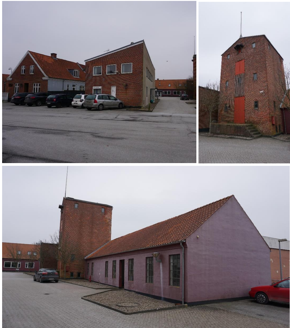
Figur 6.23: De eksisterende bygninger, bagvedliggende produktionsbygninger: De ældste produktionsbygninger. Foto: NIRAS
