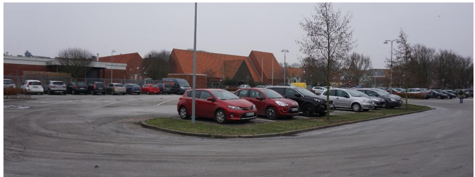
Figur 5.4: Den sydvestlige del af planområdet præges af høj grad af befæstelse i form af parkeringsarealer. Foto set mod sydøst.
